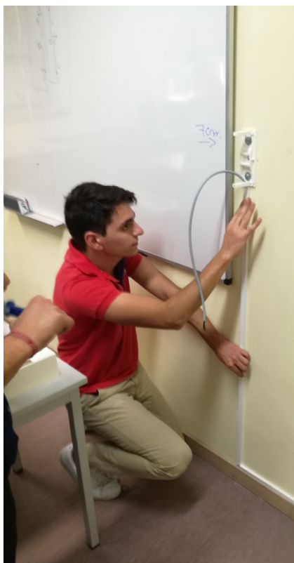
1 - Colocação do interruptor junto ao quadro
