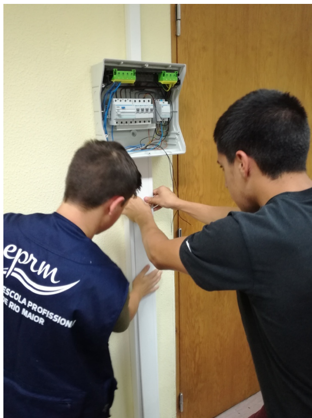
2 - Intervenção no quadro elétrico
