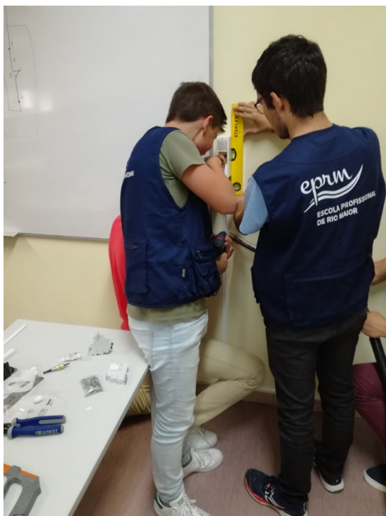
4 - Fixação de calhas
